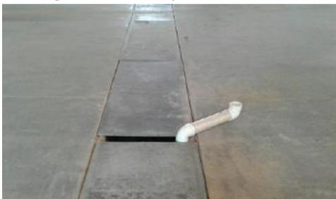
**Atenção!:** o fornecimento de água e deságue é feito por canaletas técnicas que cruzam o pavilhão de ponta a ponta. Não existe tubulação de esgoto no interior do pavilhão.
